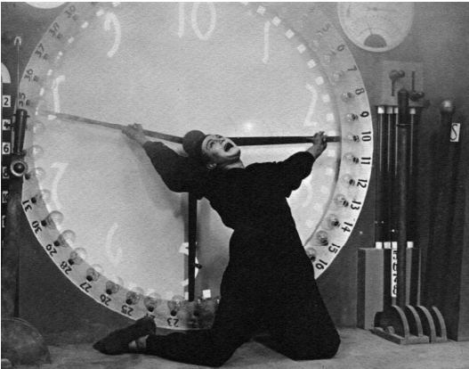
(Abb. 3: Entfremdung durch Technik – Martyrium der Arbeit)
